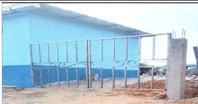
Foto 7: MEJORAMIENTO DE PORTON DE MADERA Y MALLA POR METAL
