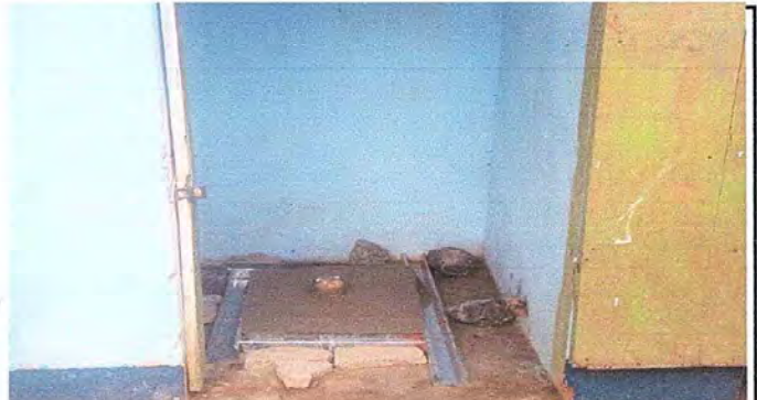
Foto 4: MEJORAMIENTO DE SANITARIOS
