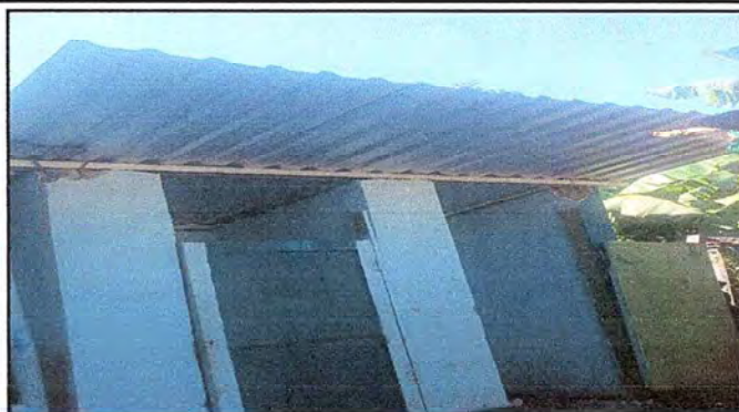
Foto 8: MEJORAMIENTO DE TECHADO DE LOS BAÑOS
