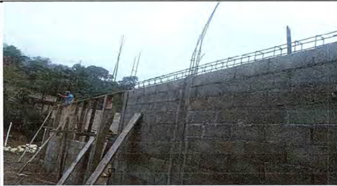
Foto 1: MEJORAMIENTO DE PAREDES DE MADERA A BLOCK
