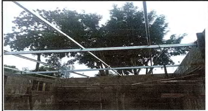
Foto 2: SUSTITUCION ESTRUCTURA DE MADERA POR METAL
